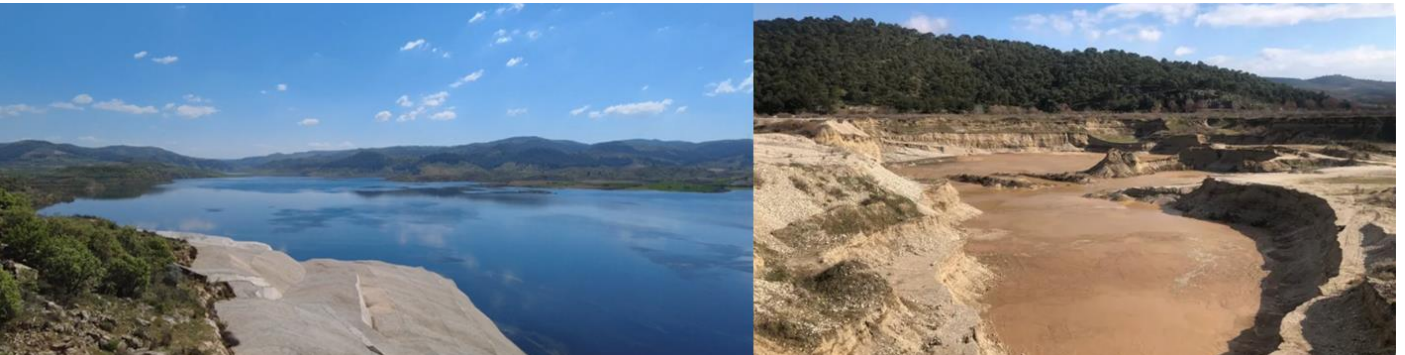
Σχήμα 4 Φράγμα Gördes: χαμηλή στάθμη υδάτων ταμειυτήρα (αριστερά) και επιχλωματώσεις κατάντη του φράγματος (δεξιά)
