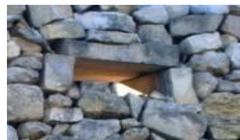
Οπή ροής στη βάση του τοίχου Μαλτέζικου τοίχου (Wied Ġhomor, Μάλτα)
