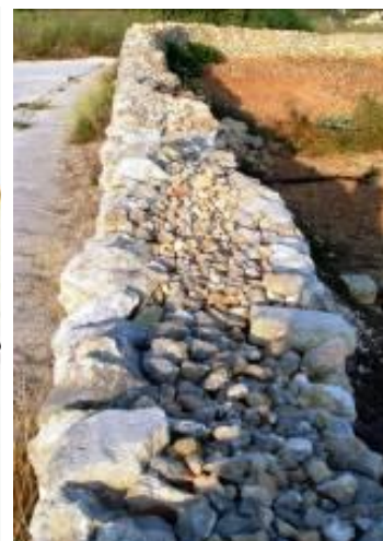
Remplissage d'un mur en moellons, 'mazkan' (Wied Għomor, Malte)
