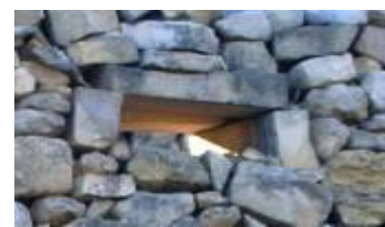
Trou d'écoulement à la base d'un mur en moellons
