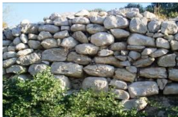
Les murs en moellons sont des murs en pierre "sèche" (Wied Qirda, Malte)
